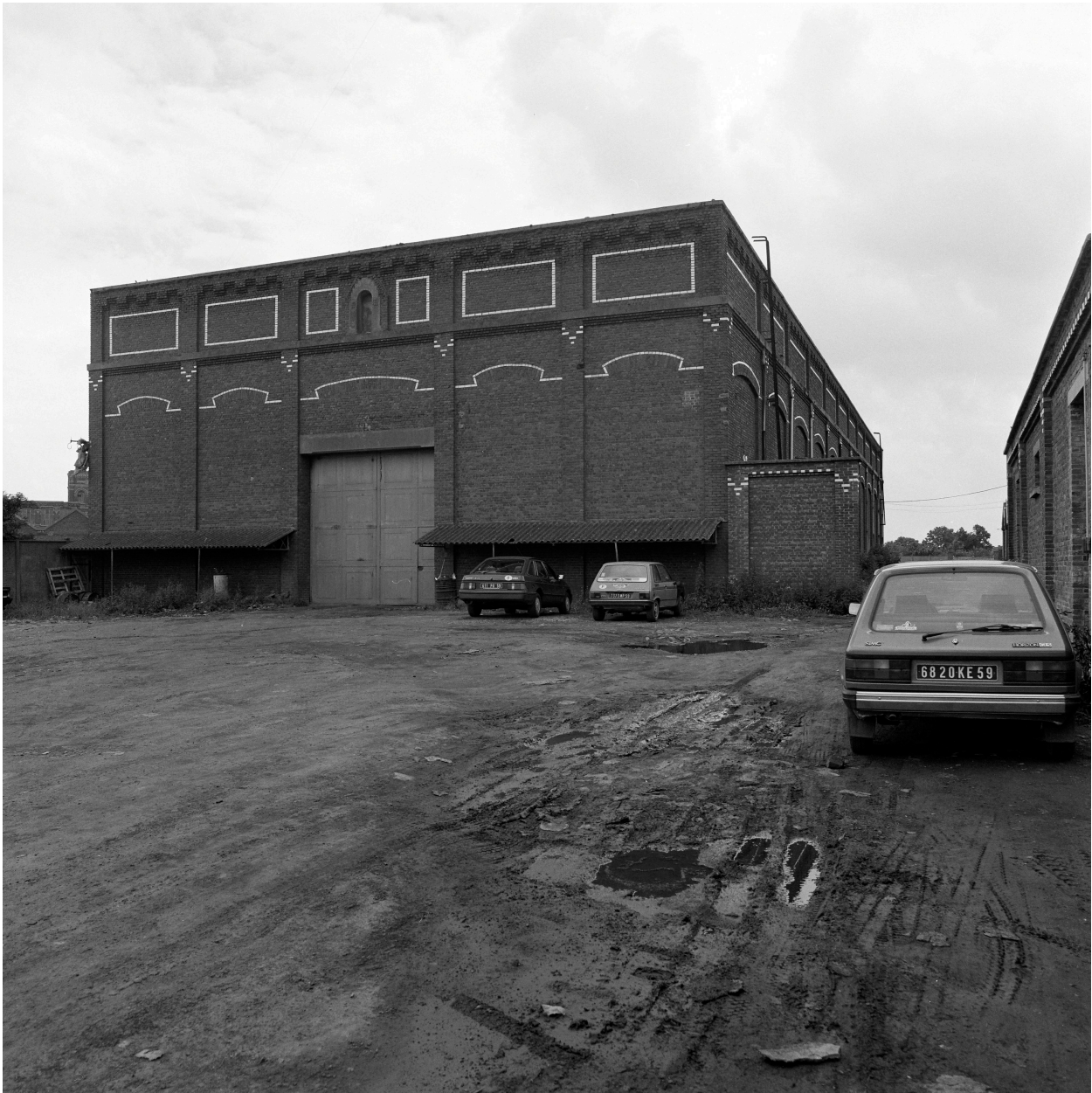
Magasin industriel, élévation nord.
