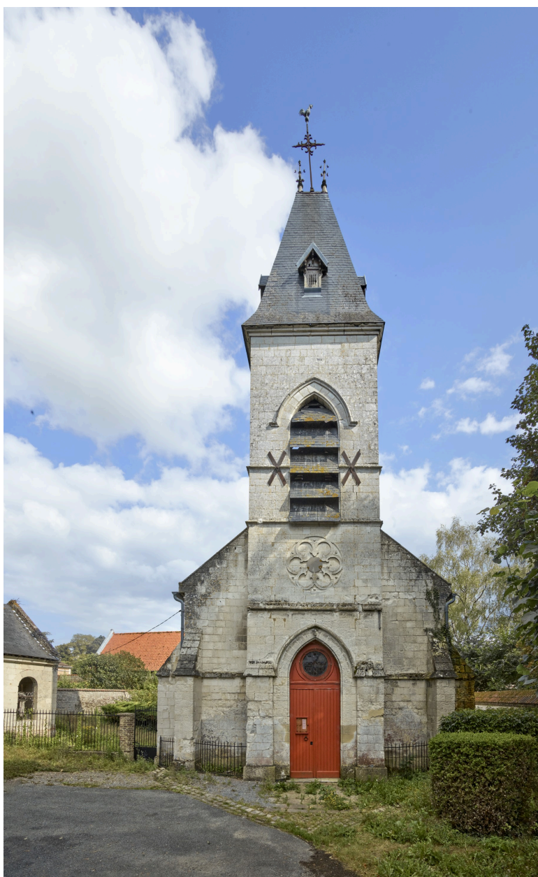
Vue du clocher-porche, depuis l'ouest.
