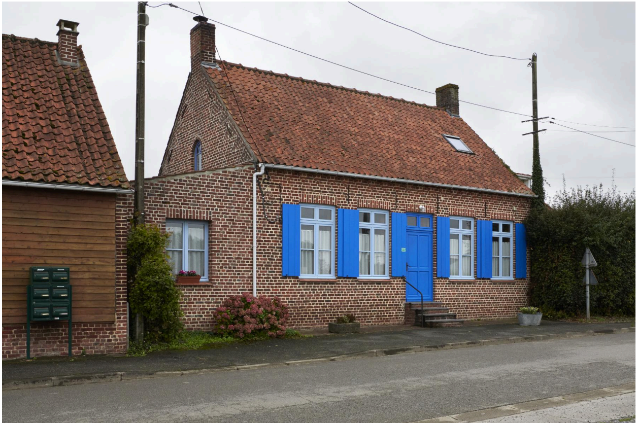
Façade est et pignon sud.
