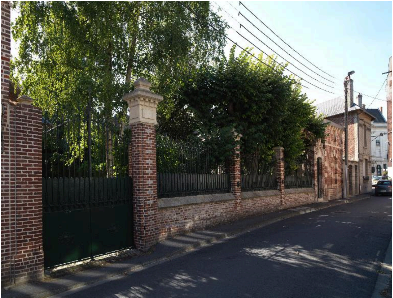
Portail et mur de clôture, rue Vadé.
