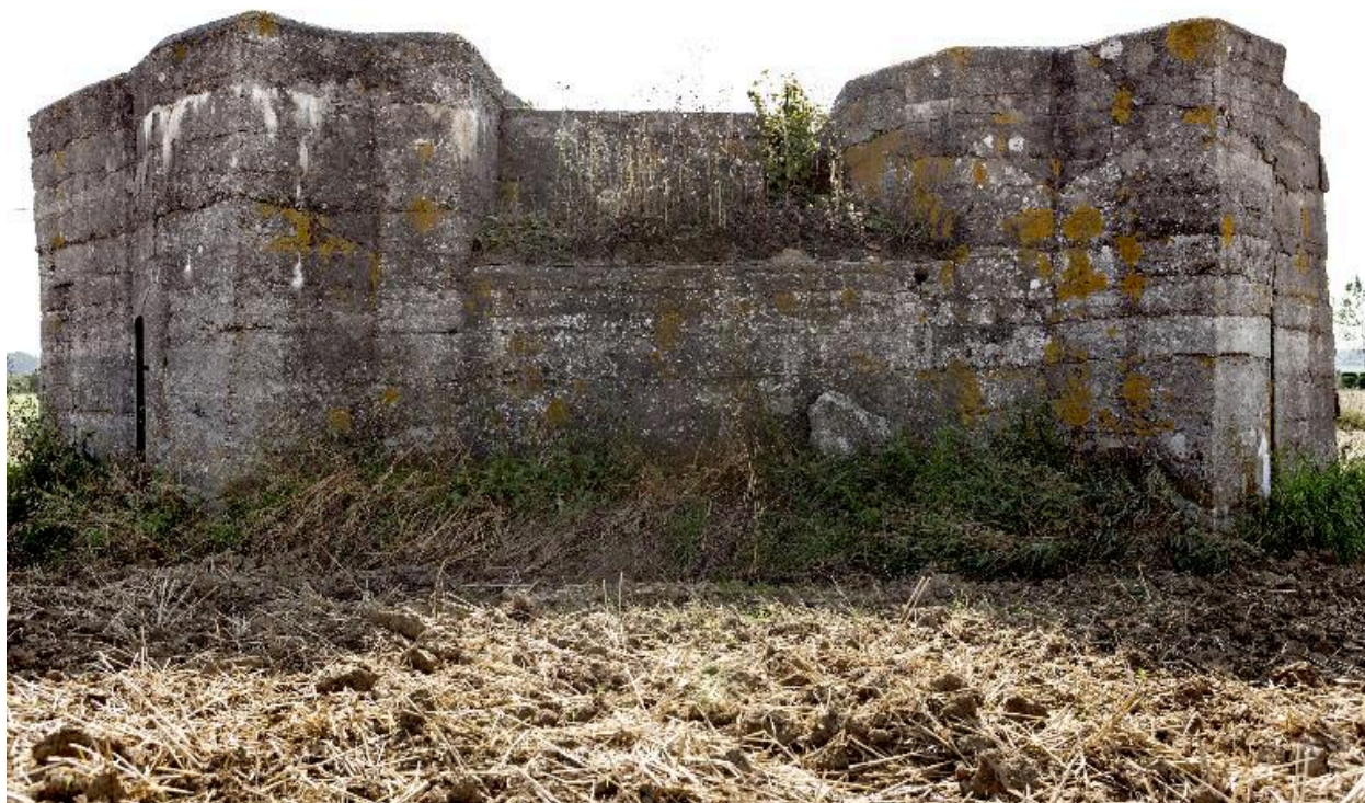
Vue antérieure vers le sud-ouest
