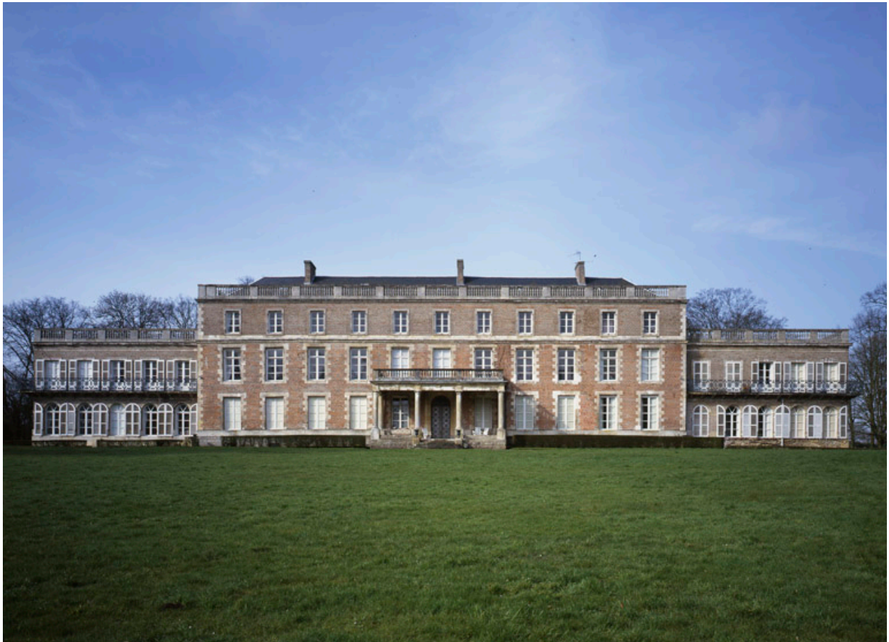
Le corps de logis : élévation orientale.
