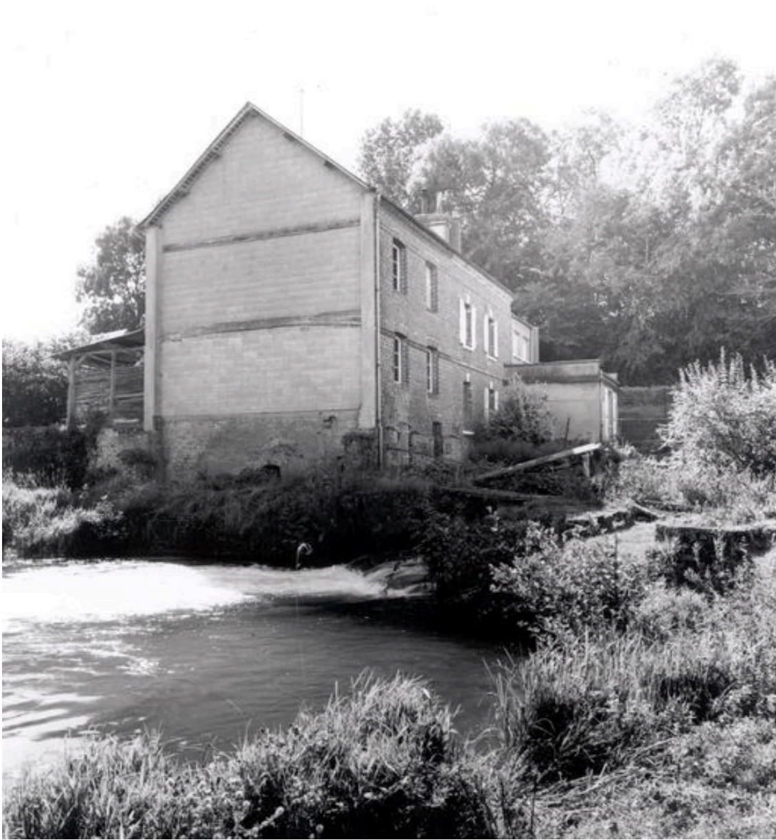
Vue d'ensemble du pignon reconstruit du moulin, depuis le déversoir.
