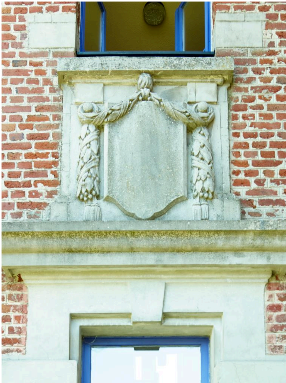
Détail d'un panneau décoratif sur la façade rue de la République.
