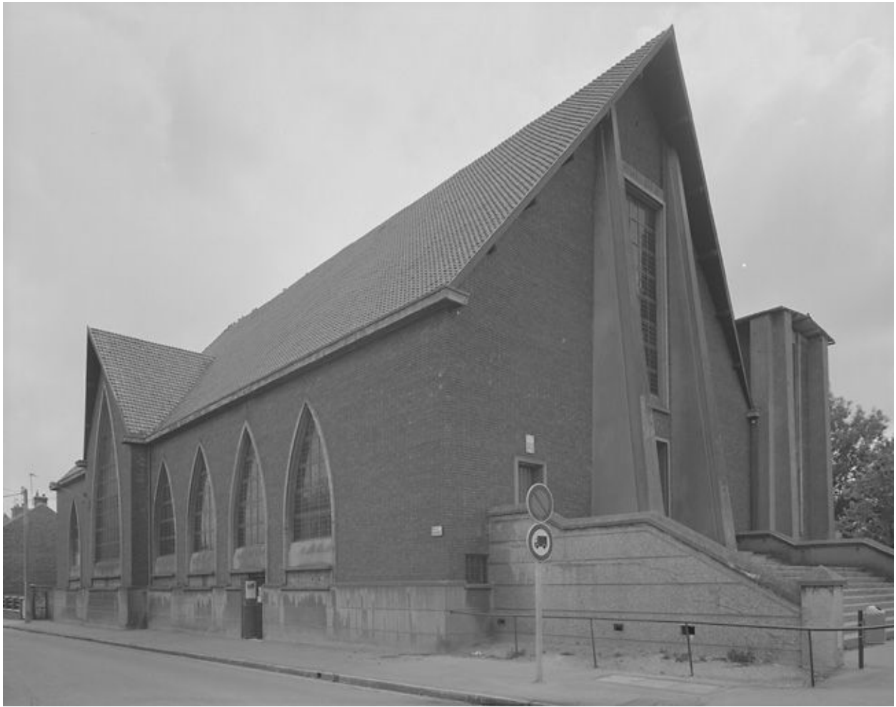
Vue générale sur la façade nord.
