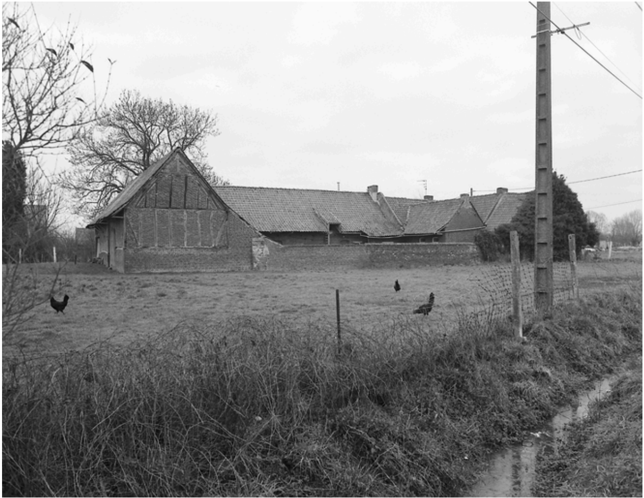
Ferme, rue du Faux, pan de bois dans le mur de la grange.
