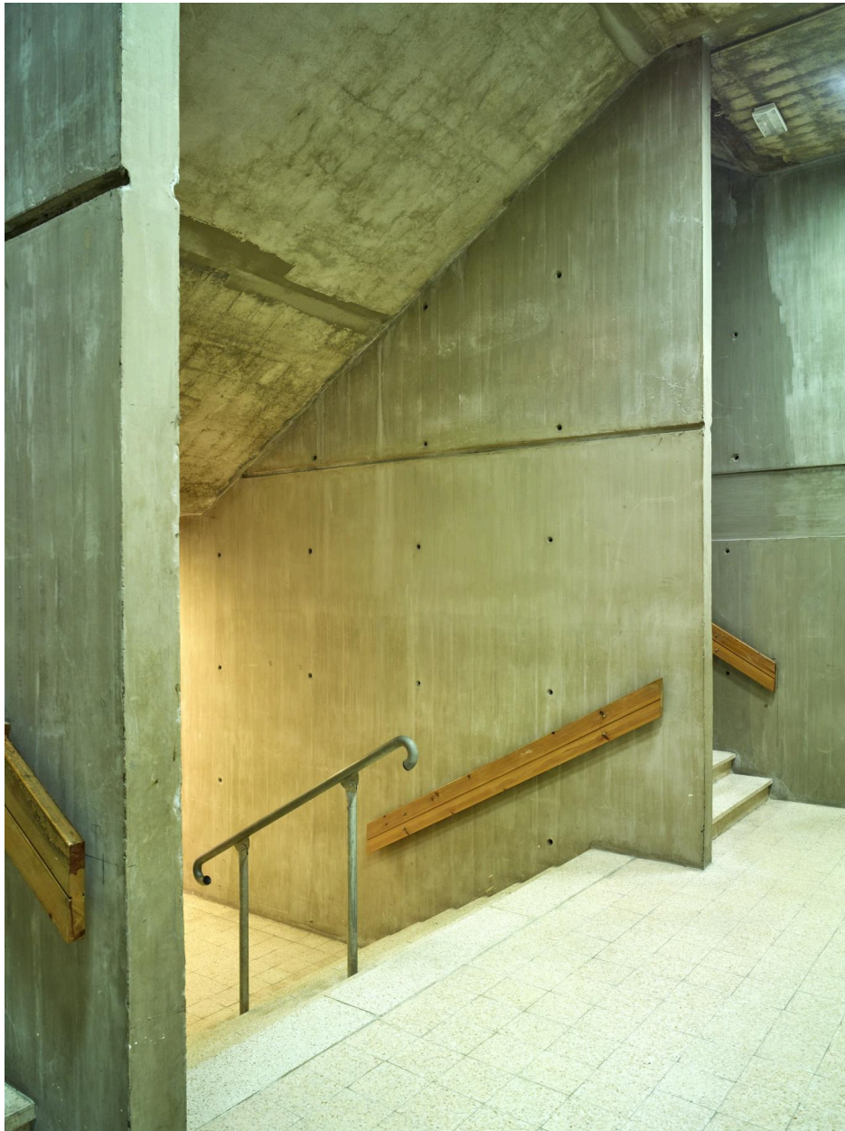
Détail des escaliers intérieurs : le béton est laissé brut.
