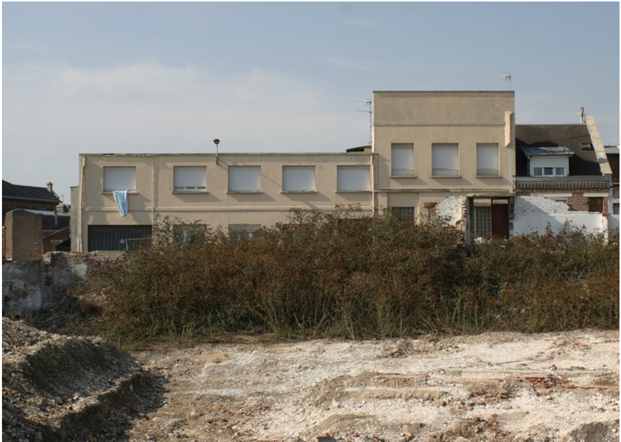
Façade antérieure, rue de la Grange.
