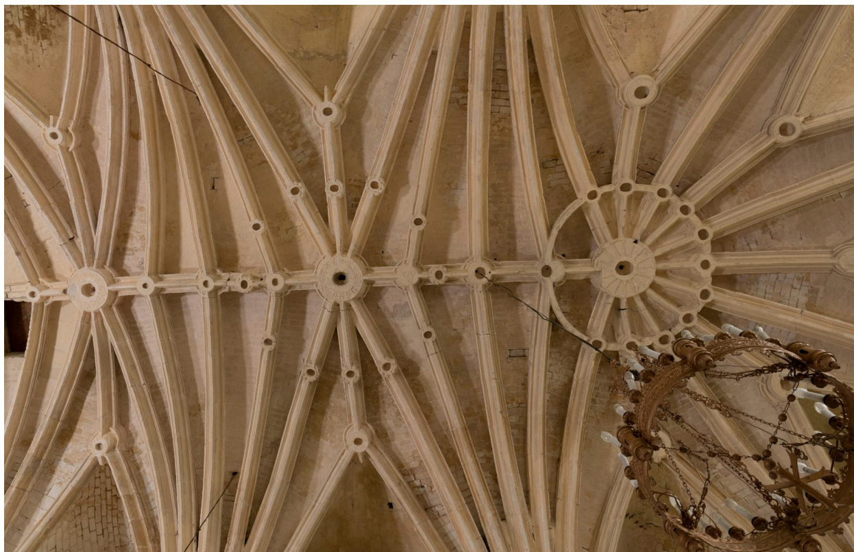
Voûtes du sanctuaire et des deux travées du chœur.
