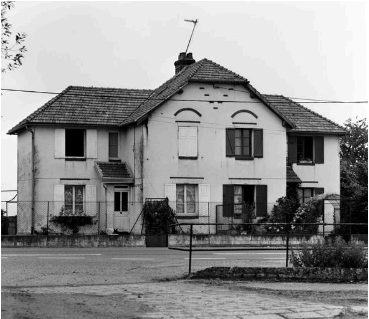
Logement d'ouvriers des années 1930 : façade est.
