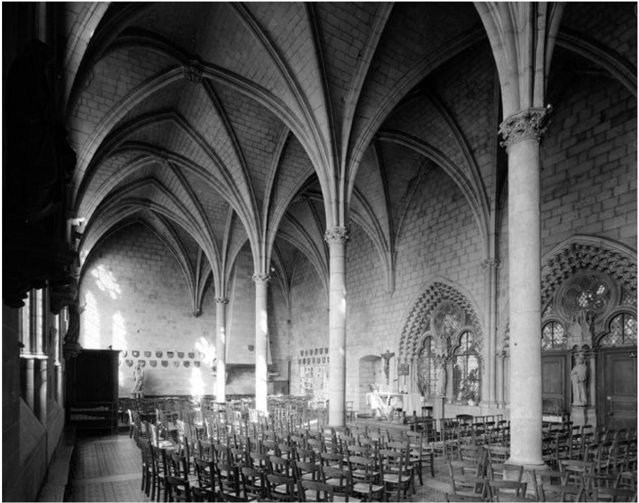
La salle capitulaire. Vue intérieure depuis l'angle nord-est.
