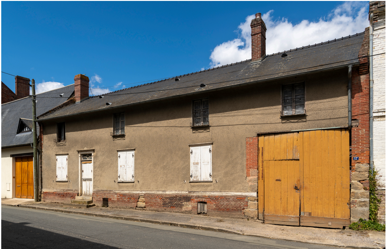
Logis sur rue, n°17 de la rue du Bail, vue depuis le sud.
