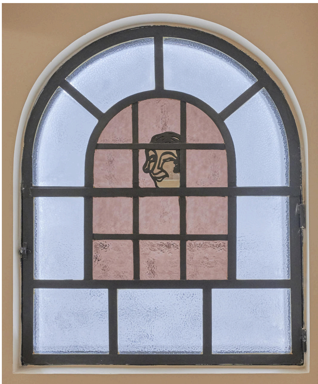
Verrière de la cage d'escalier.
