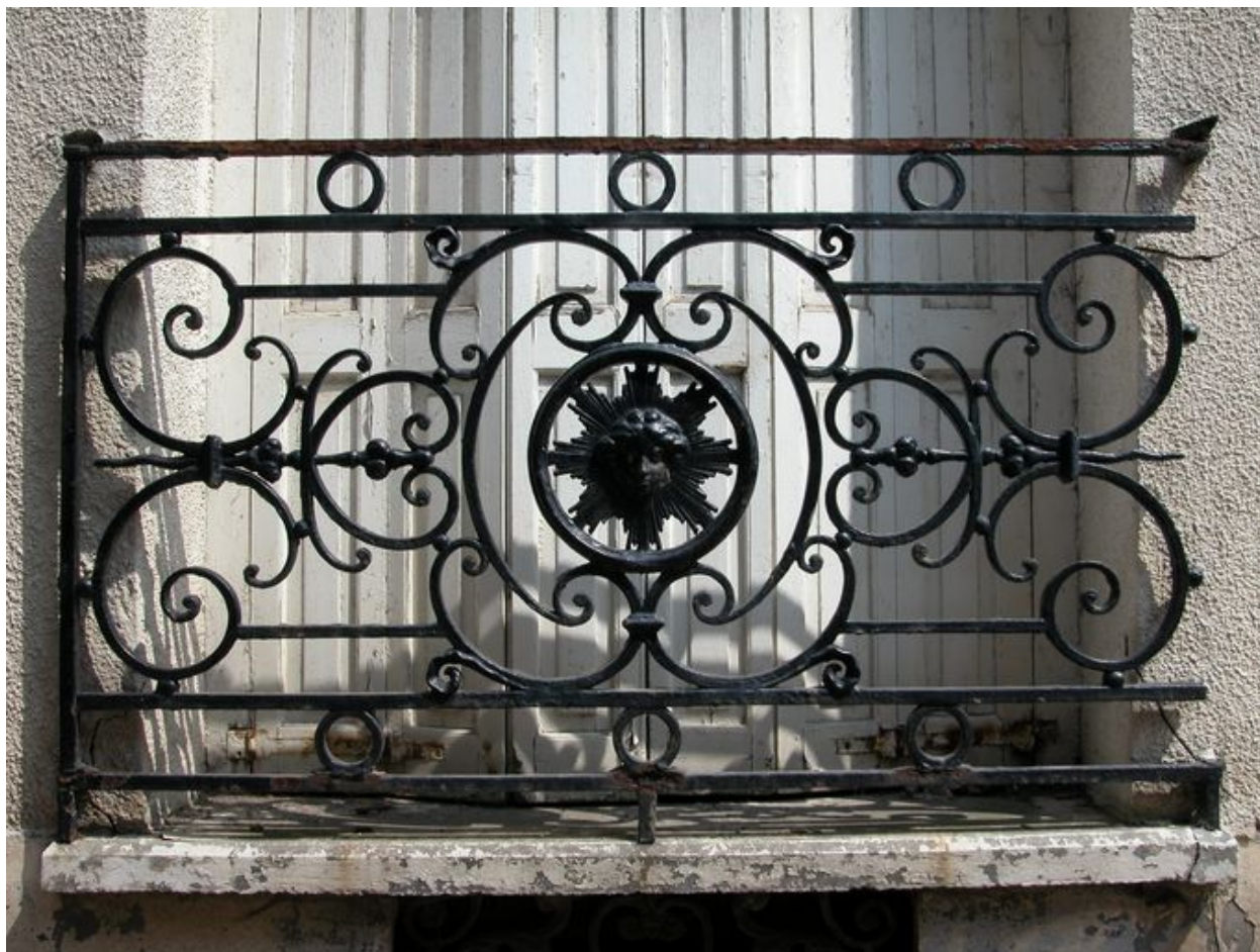
Détail de la ferronnerie du rez-de-chaussée.
