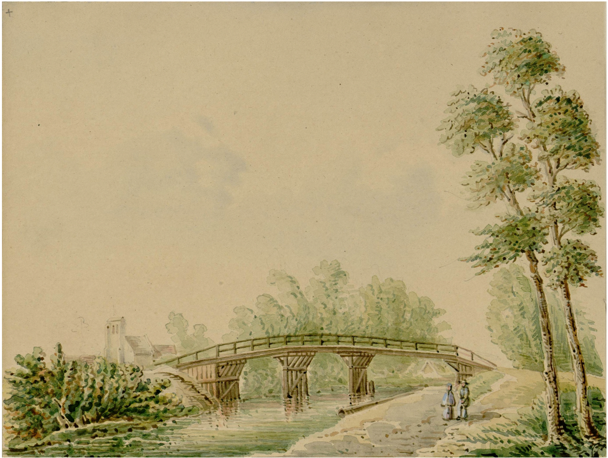
Pont nouvellement construit sur la Somme à Épagnette, par Oswald Macqueron, d'après nature, 29 avril 1887 (Archives et Bibliothèque patrimoniale d'Abbeville ; Ab.M46).
