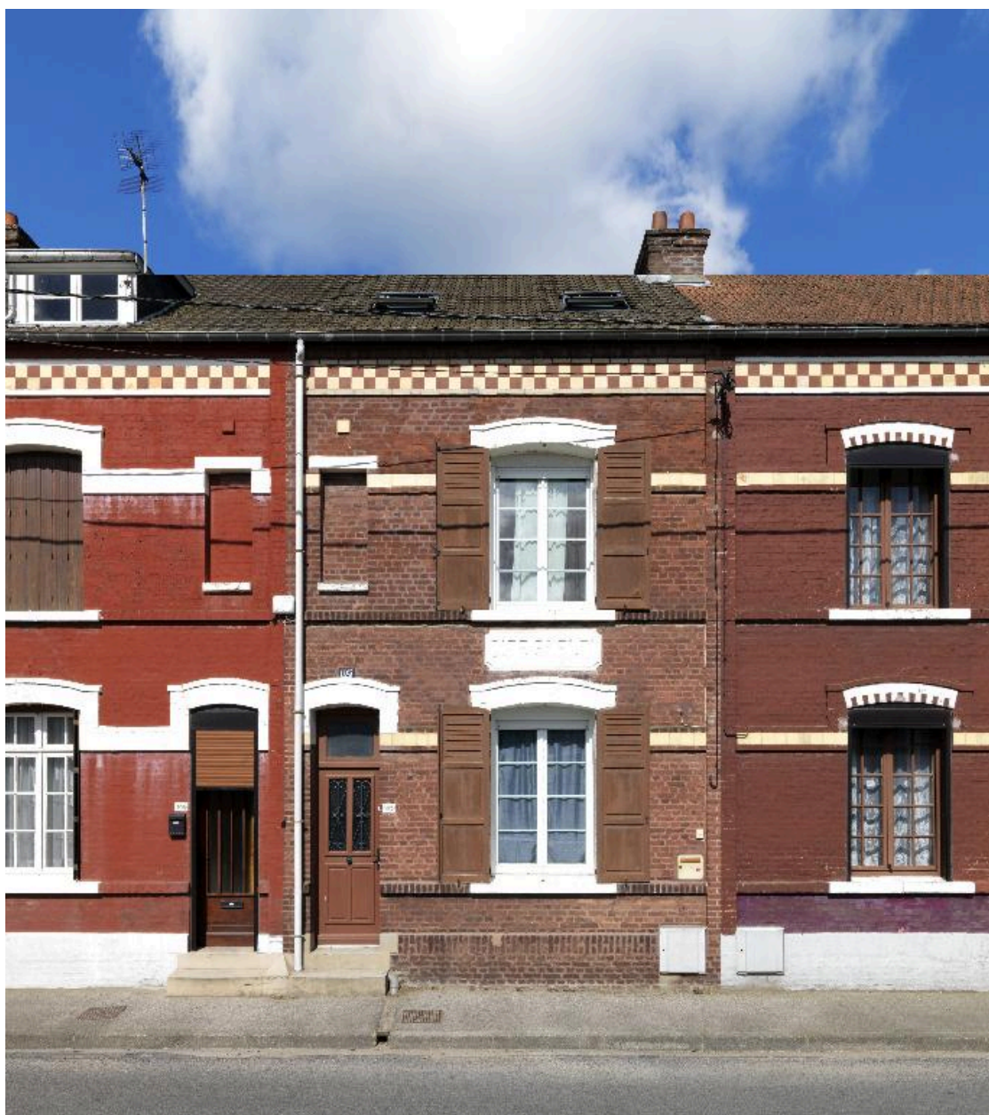
Vue d'un des logements.
