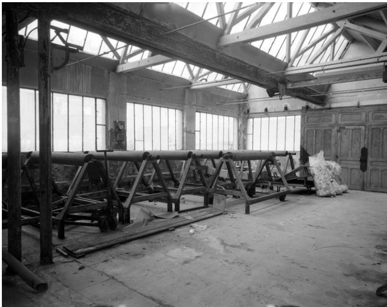
Vue intérieure des anciens ateliers de fabrication.
