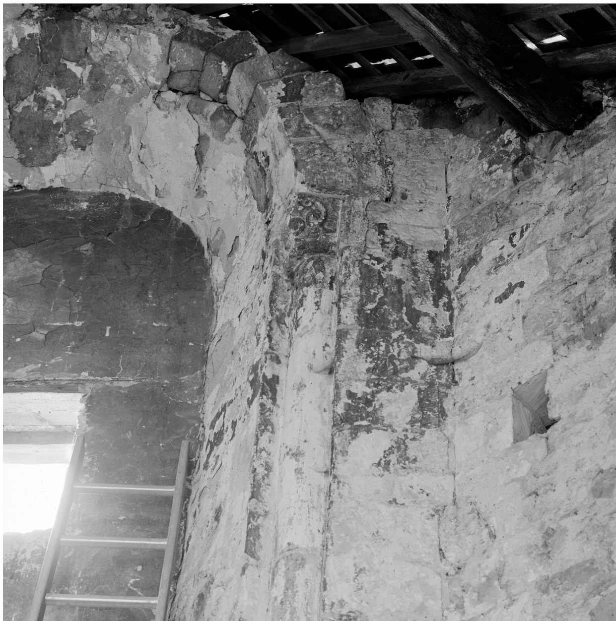
Bâtiment dans la cour, entrée 5 rue Henry, abside, pan sud, chapiteau sud.
