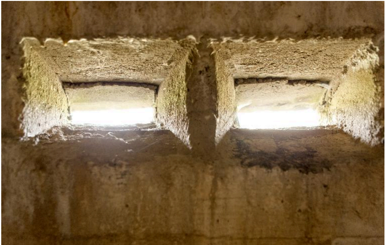
Casemate b. Vue intérieure de l'observatoire bétonné. Embrasures de surveillance
