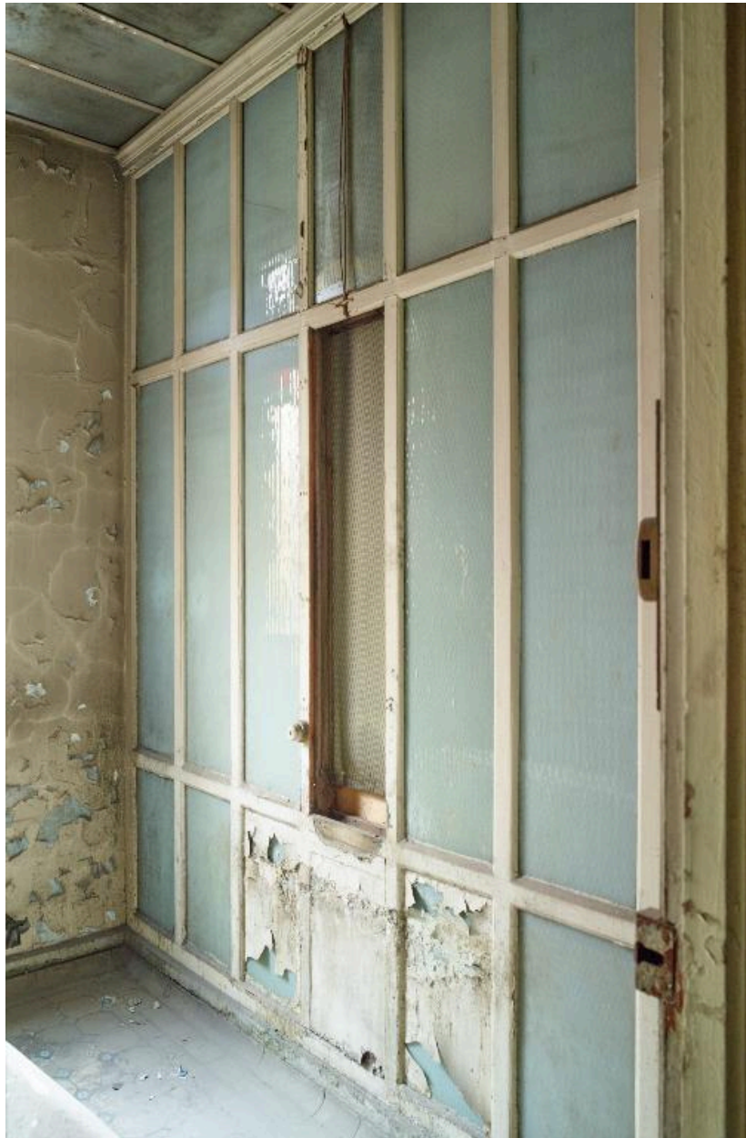
Aile nord, premier étage. Bains de baignoires de luxe pour hommes. Vue de trois quarts de la troisième cabine à gauche. Détail de la cloison.
