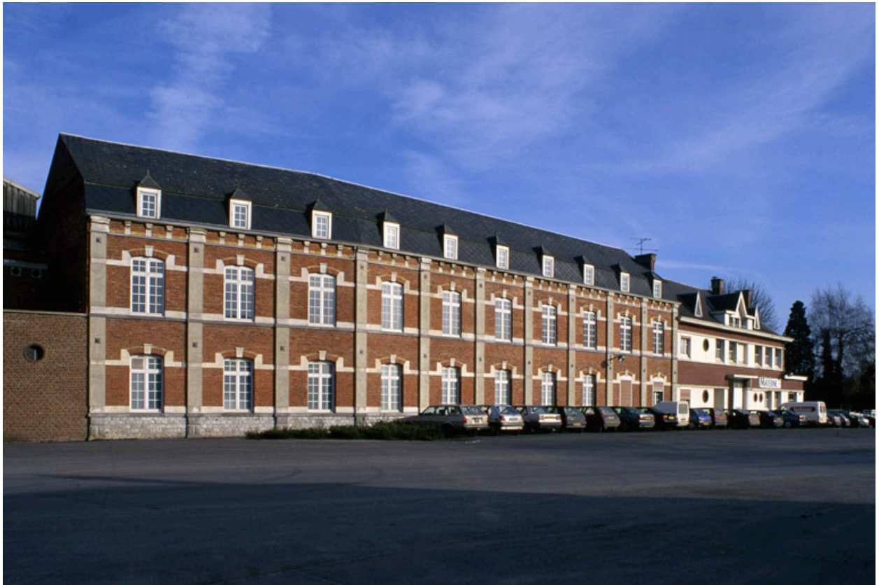
Façade de l'atelier de fabrication reconstruit vers 1922.
