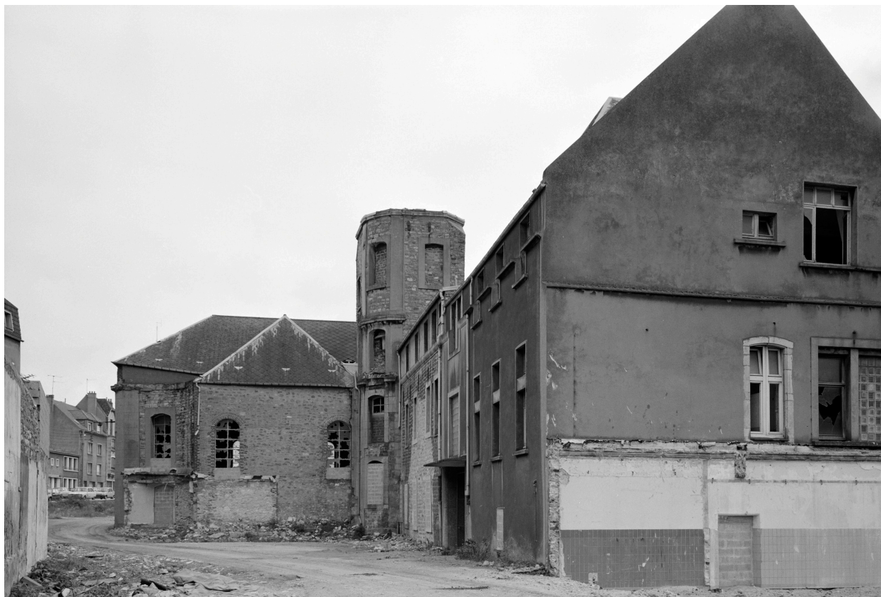
Bâtiment C, chapelle : vue d'ensemble ouest.
