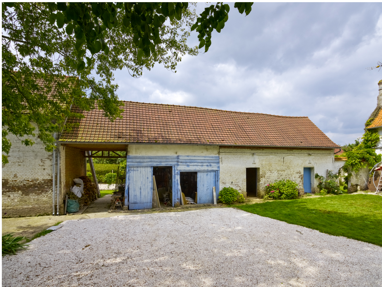
Second bâtiment agricole, depuis le nord-ouest.
