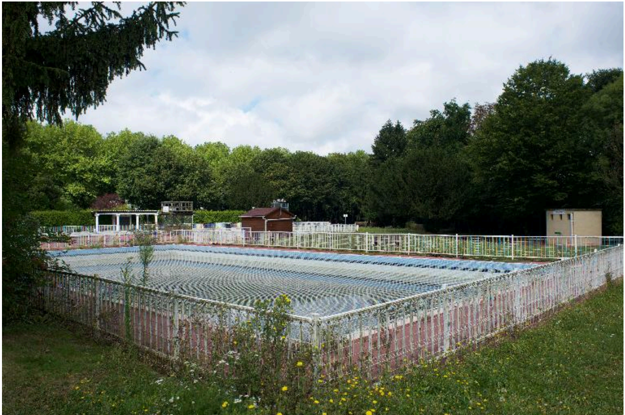
Vue du bassin extérieur de 25 m (construit en 1971).
