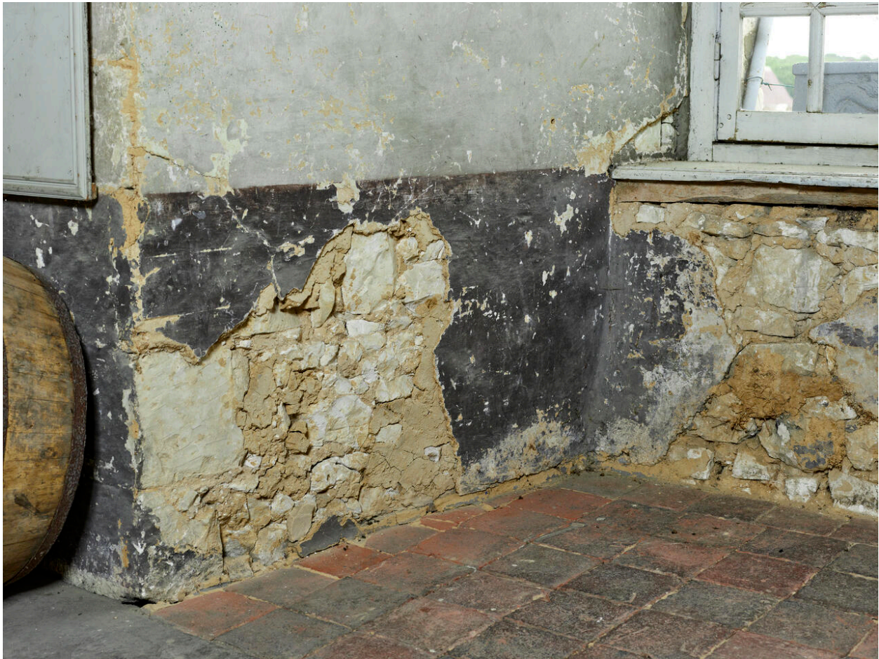
Intérieur de la salle du Conseil d'échevinage, au premier étage du beffroi. Détail du mur intérieur composé de moellons équarris recouvert d'un enduit en torchis.
