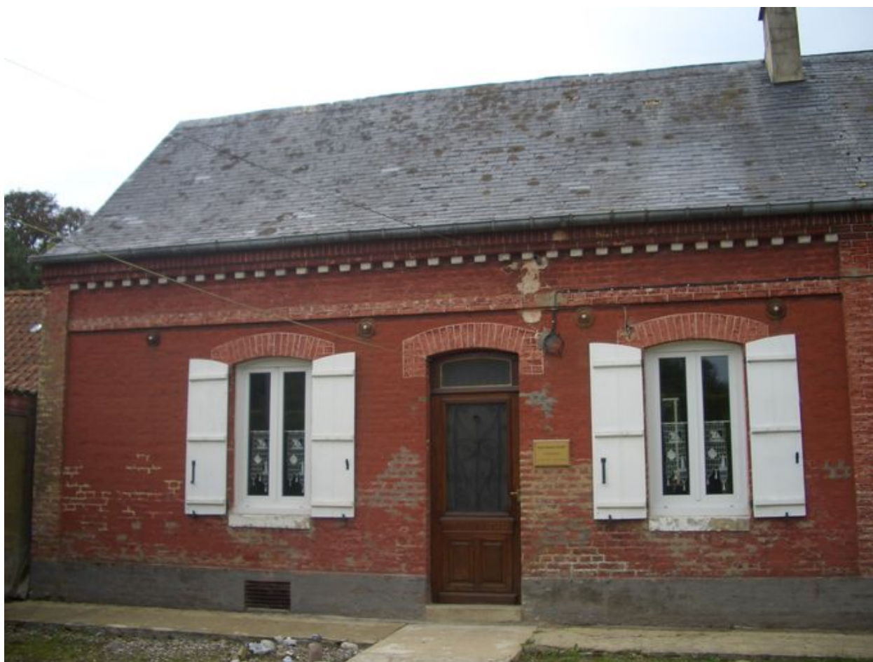
Vue de la partie habitation.
