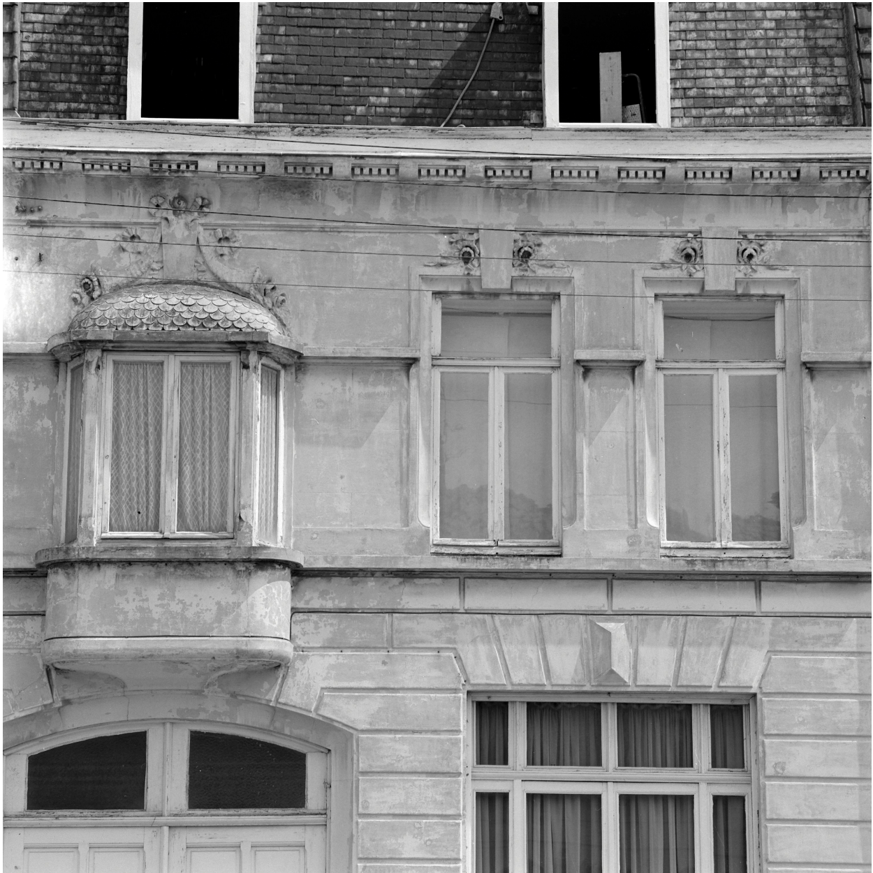
Élévation rue Jules-Ferry. Détail du premier étage.
