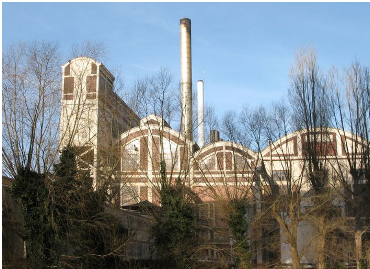
Elévation de la centrale vapeur, façade sud.
