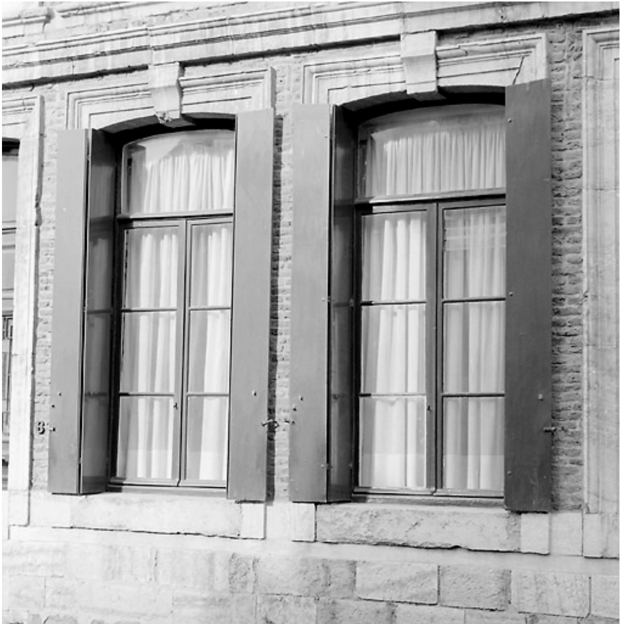
Façade rue de l'Escaut, rez-de-chaussée, vue partielle : baies.
