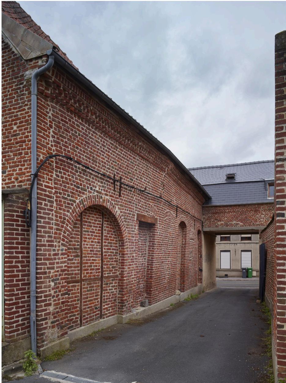
Façade latérale de l'entrepôt vue depuis la cour.
