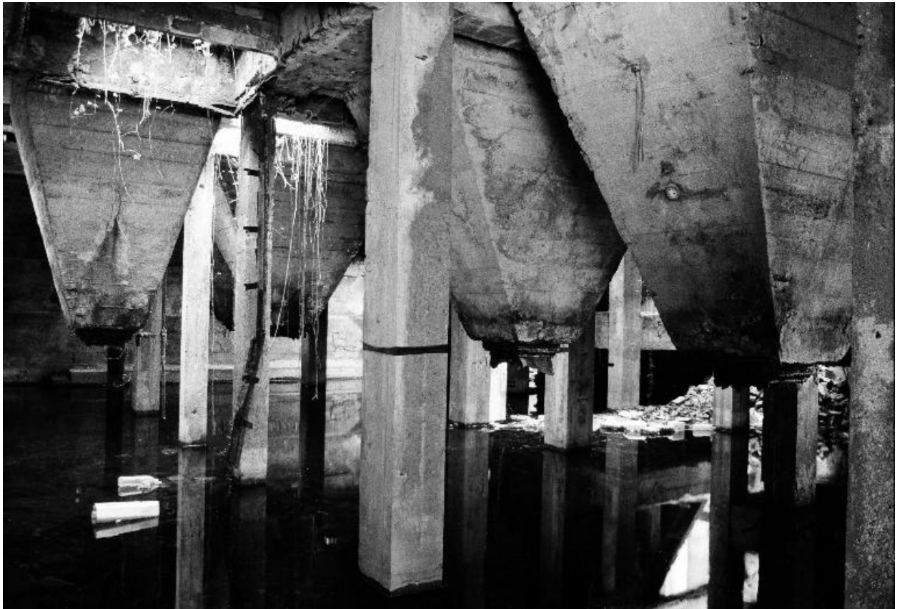
Atelier, rez-de chaussée, salle des goulottes, détail.
