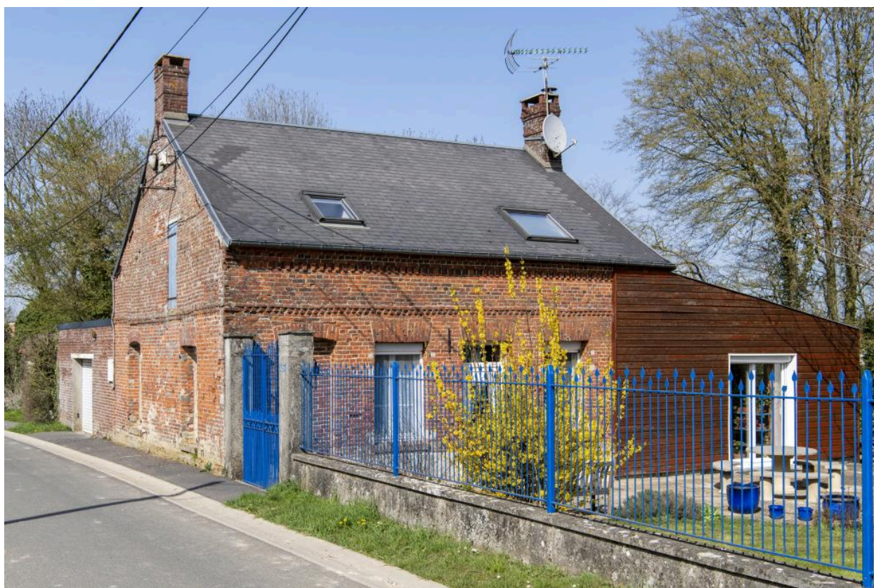
Maison, n°29 rue des Fresnes, vue depuis le sud.
