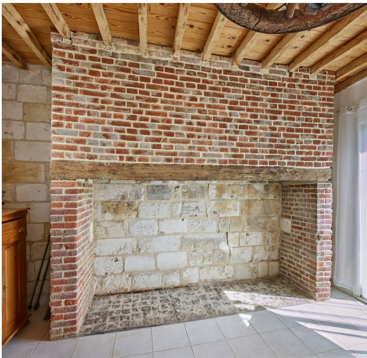
Cheminée du bâtiment au sud du manoir.
