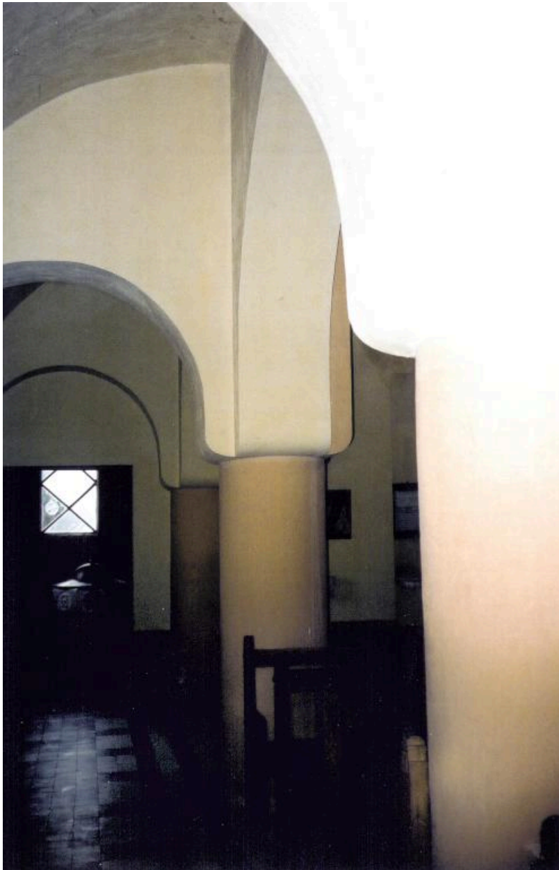
Vue intérieure : détail du pilier des bas-côtés.
