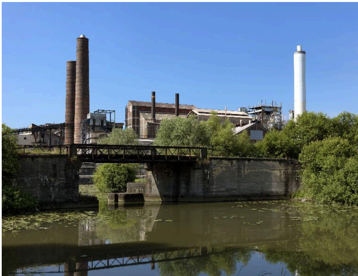
Vue d'ensemble de la sucrierie depuis le chemin de halage.
