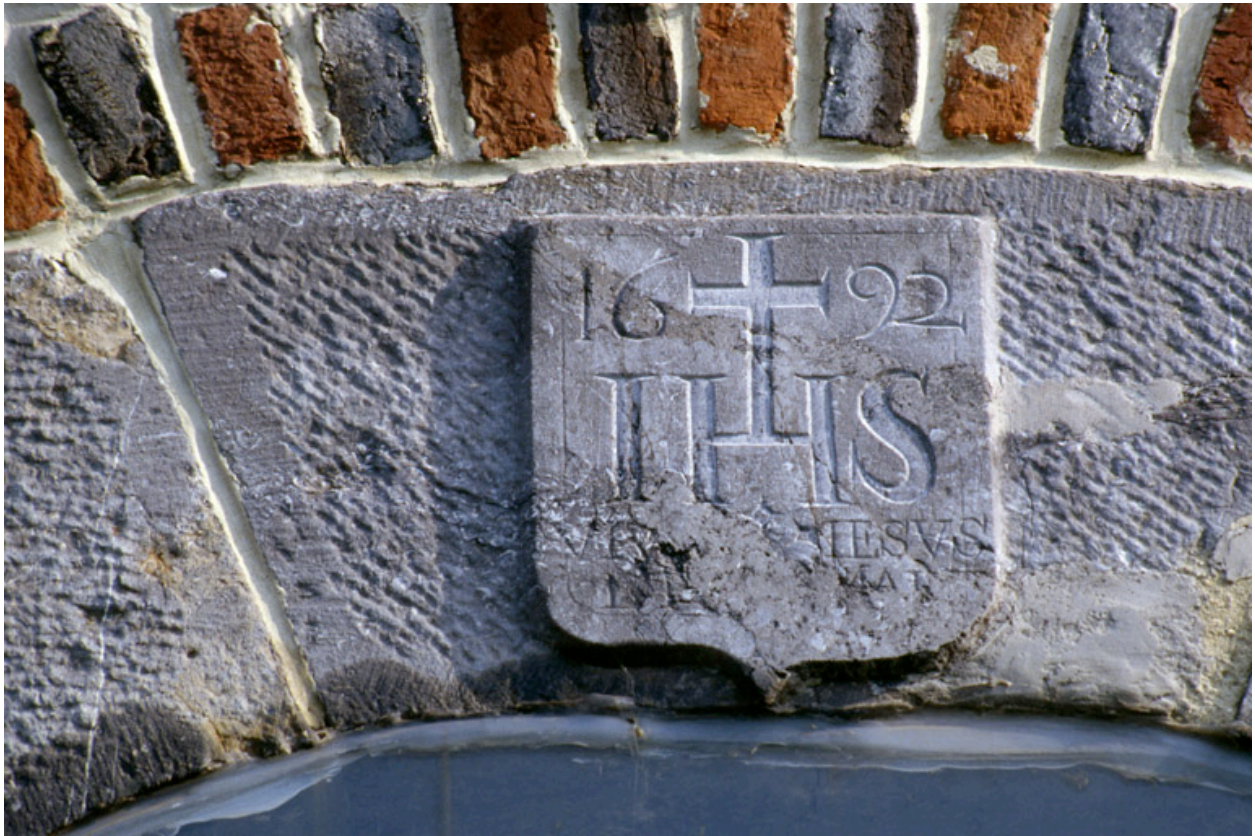
Barzy-en-Thiérache, maison (repérée), 57 Grande-Rue : linteau de la porte portant la date 1692.
