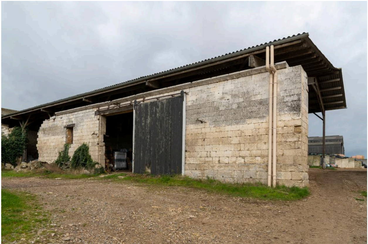
Vue depuis le sud-est de l'ancienne grange de la ferme du château, en pierre et en pans de bois et torchis, 18e siècle (?)
