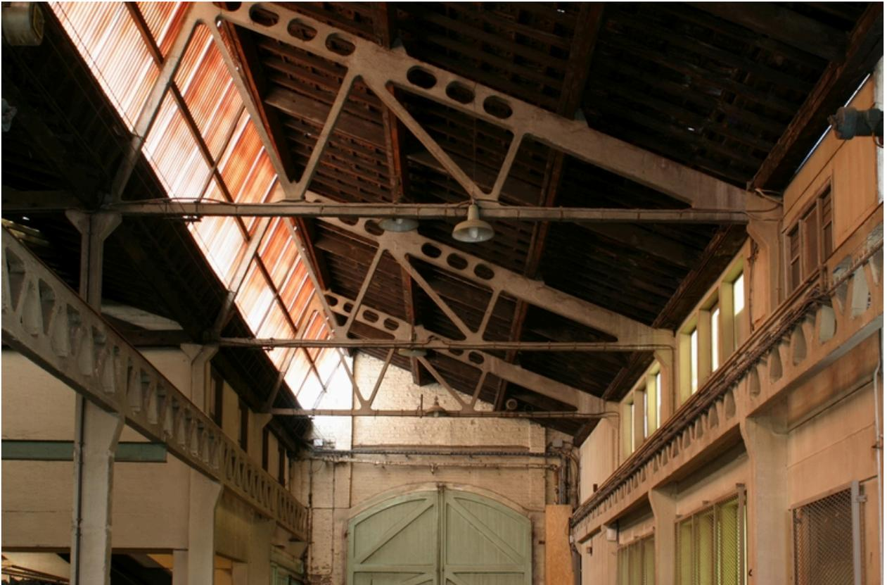
Ancien atelier de mécanique : détail de la structure porteuse et de la charpente, en béton armé.
