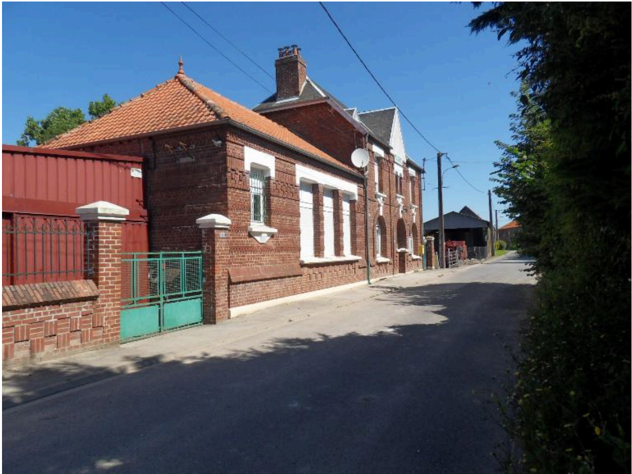
Vue de situation depuis le sud. Au premier plan, le portail sur la cour et la salle de classe.
