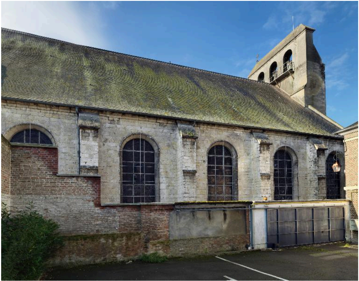
Vue extérieure de la nef du côté est.
