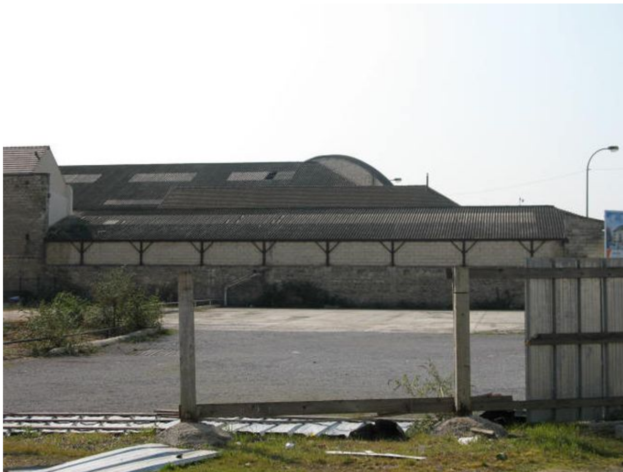
Succession de toitures des entrepôts Boufflette.
