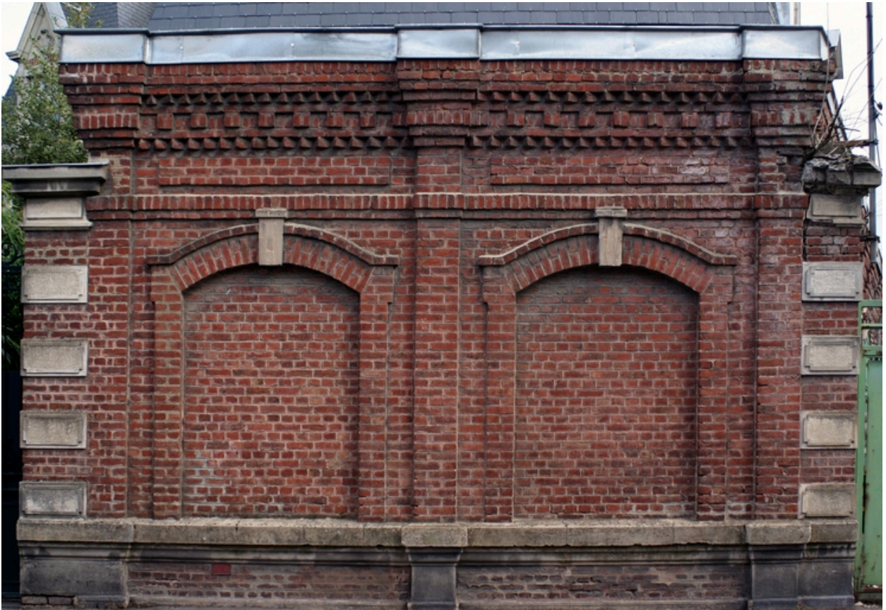
Pignon de la conciergerie.
