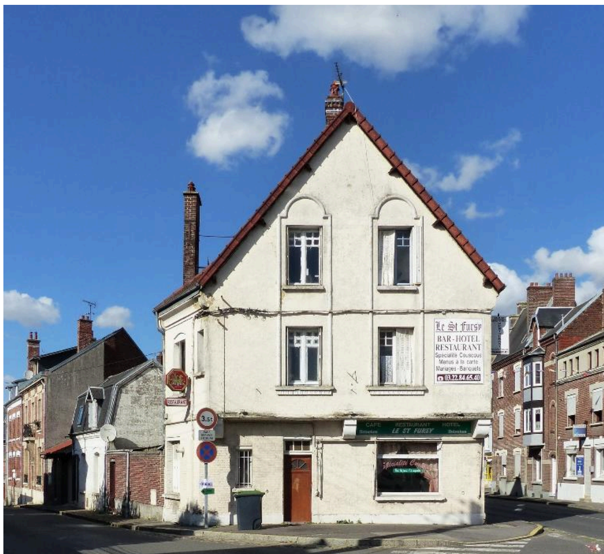
Vue de la façade sud.
