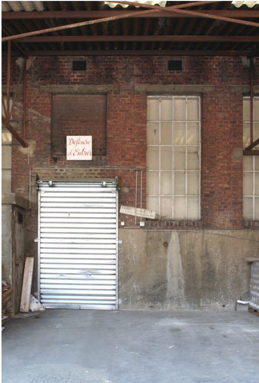
Fournil (façade sur cour).
