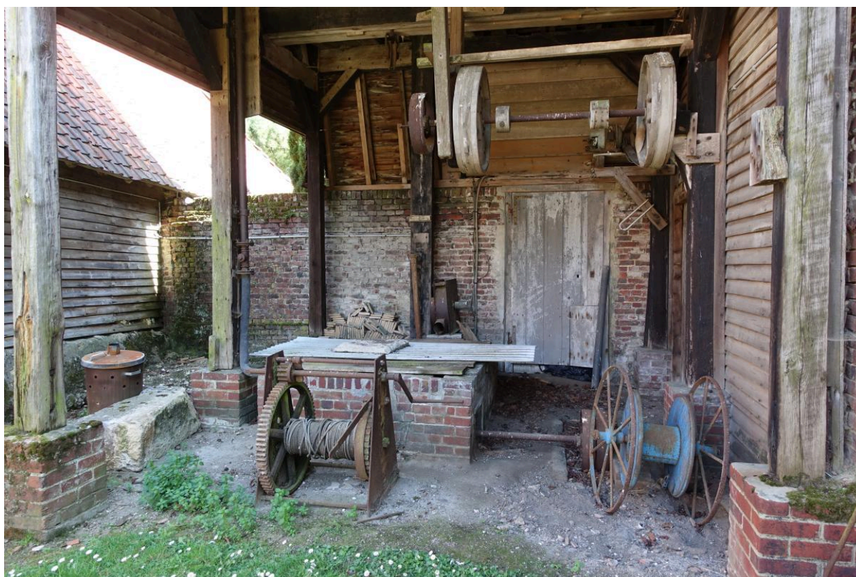
Détail du mécanisme de pompage du puits.
