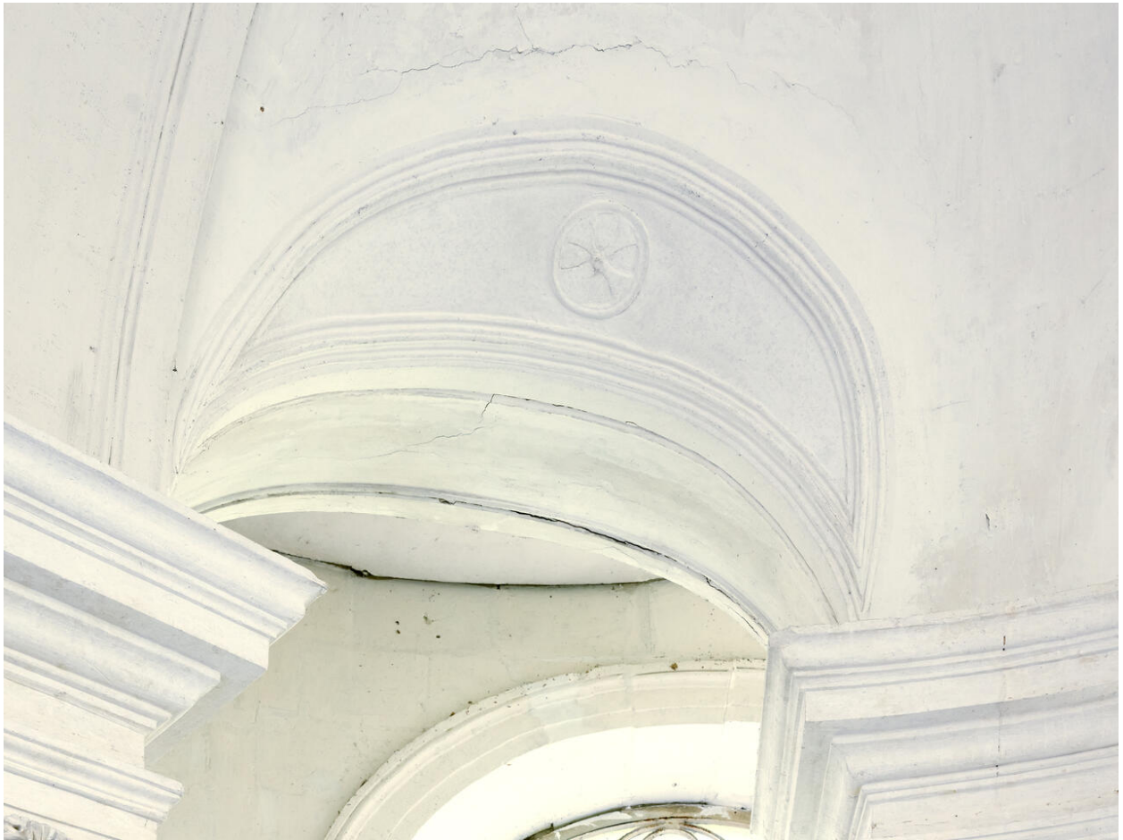
Vue de détail de la voûte en cul-de-four de l'abside : motif de croix pattée alésée arrondie.
